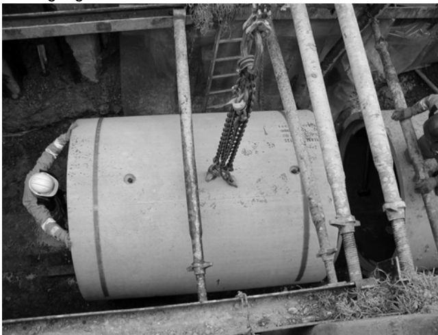
Verlegung des Rohres NW 1'600 mm
