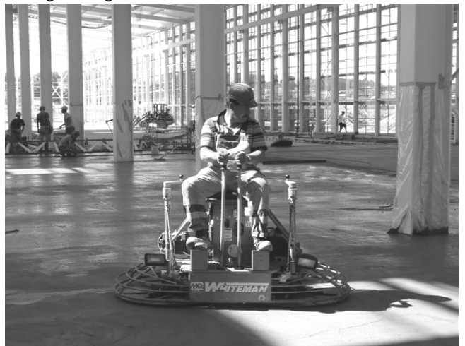
Fertigstellung der Monobeton-Oberfläche
