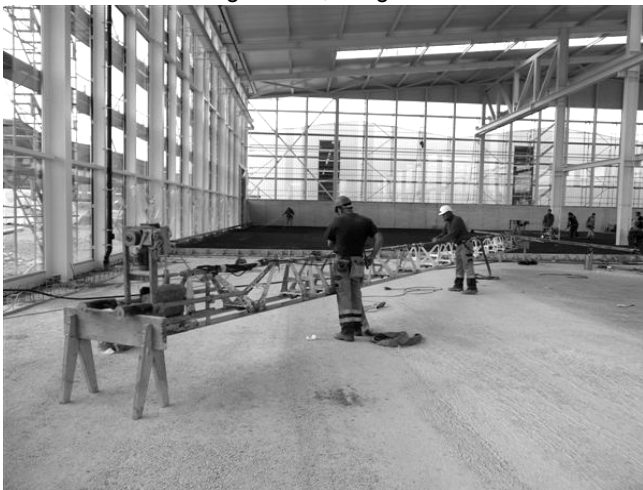
Montieren des Abzugsbalken, Länge 17 m
