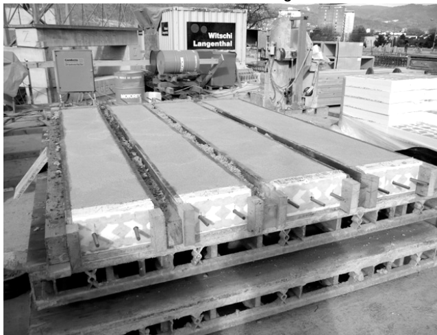
Vorfabrikat. von Betonstützen mit integr. Thermoisolation
