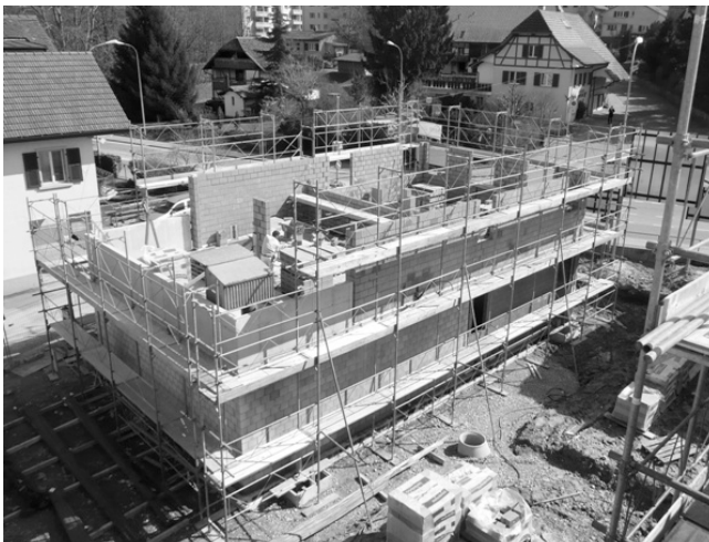
Rohbau Mehrfamilienhaus G
